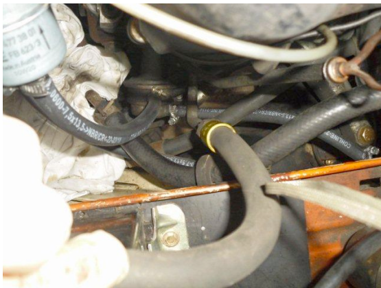
Abbildung 6: Blick von links/oben auf die Kraftstoffpumpe; man erkennt die gewechselten Kraftstoffschläuche und oben links im Bild den Kraftstofffilter
